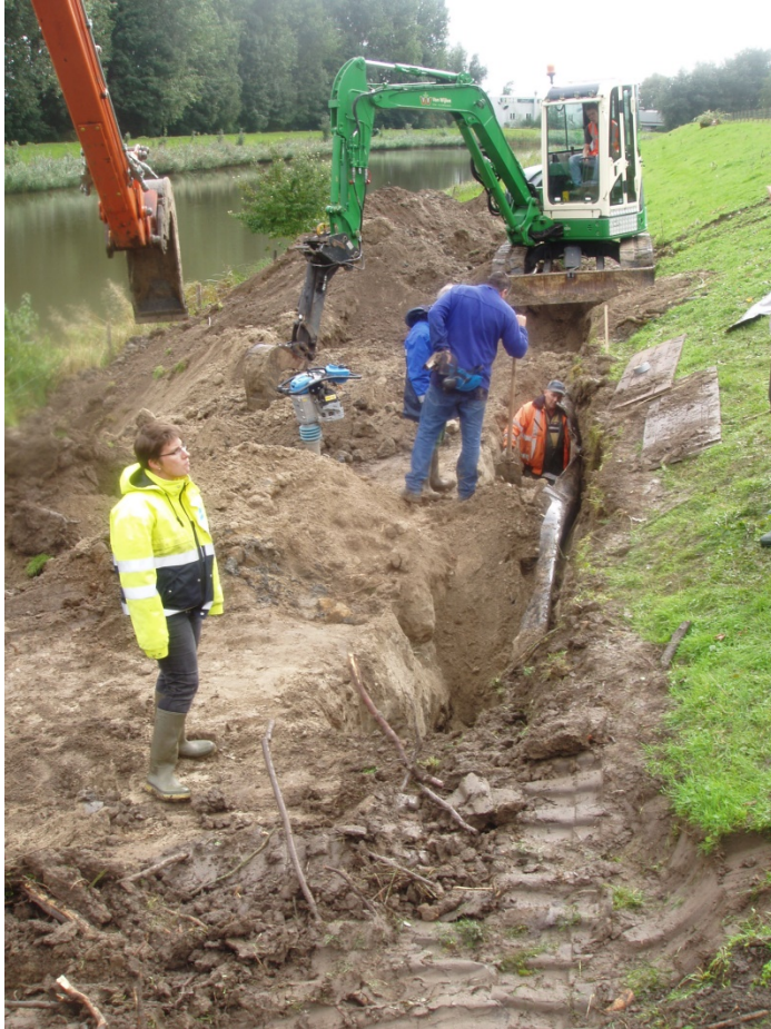
Figuur 7.2. Het opengraven van beverholen in de primaire waterkering bij Waalwijk, oktober 2015 (Foto: Vilmar Dijkstra).
