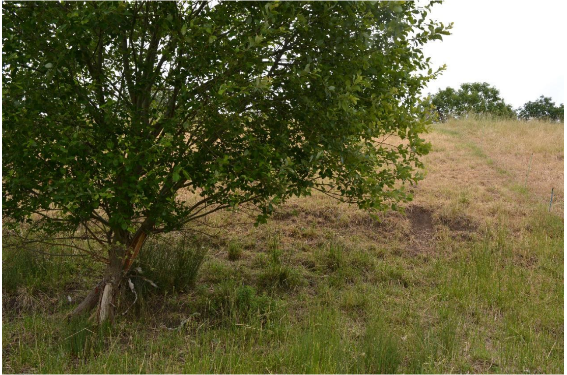
Figuur 1 Steiler gedeelte van binnentalud Prosperdijk met één volledig kaalgeschuurde plek na beweiding met schapen. Foto van 8 juni 2020.
