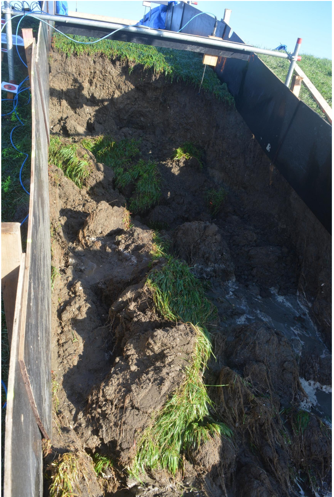
Figuur 7 Vossenhol op Hedwigedijk na beproeving op 23 november 2020 met 180 liter per seconde per 2 meter gedurende 1 uur en 13 minuten.
