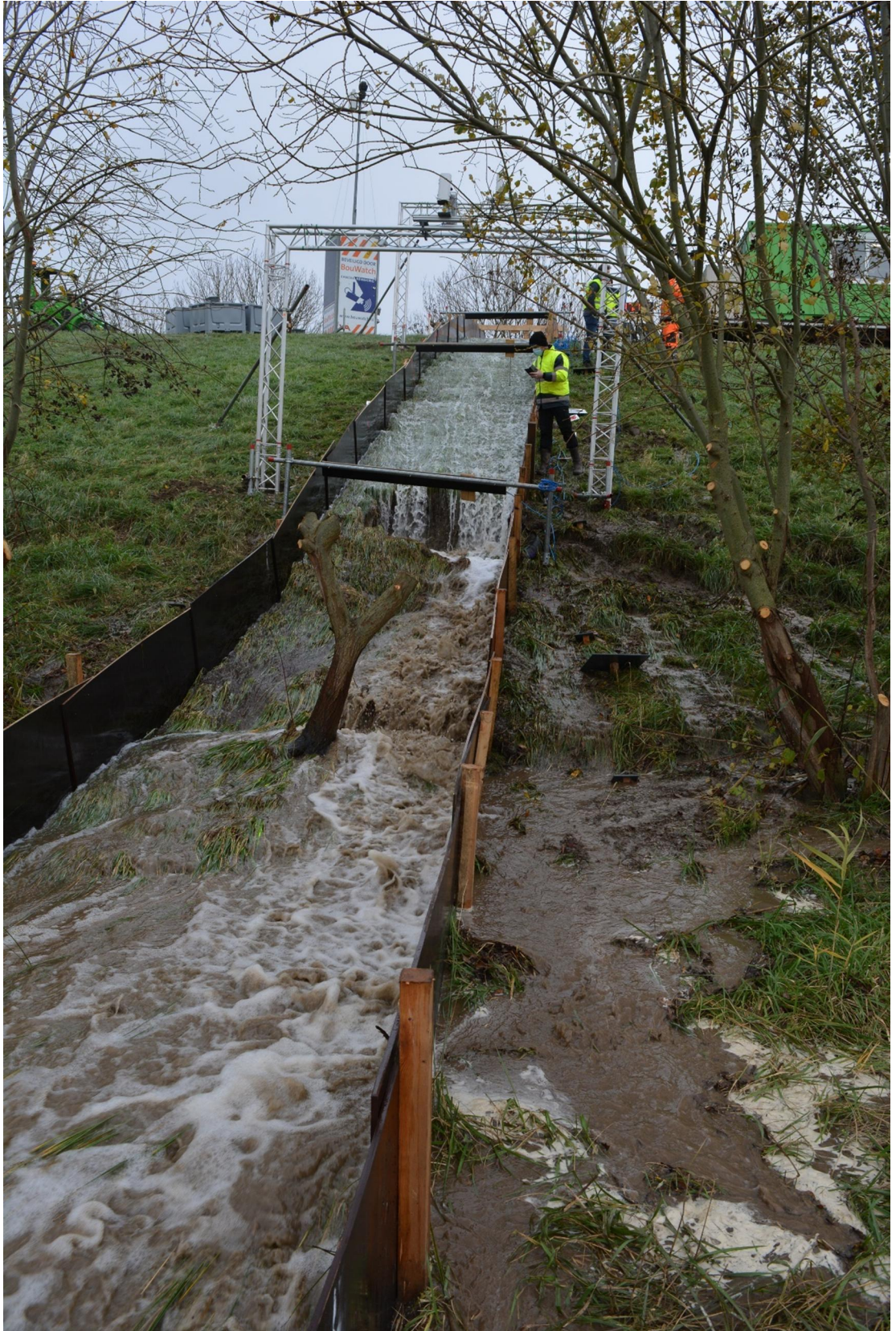
Figuur 4 Overloopproof met boom op 17 november 2020, na stopzetten van de pomp. Rechts van de proefopstelling drie zandmeevoerende hopen, links ervan één nauwelijks zandmeevoerend hol.
