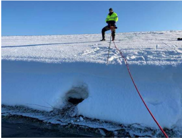
Figuur 1 Het gemiste beverhol na daling van hoog water [WDOD, 2021]
