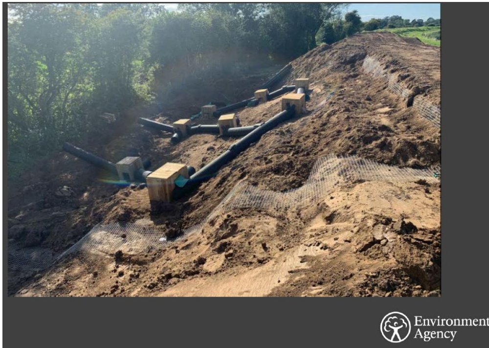
Figuur 11 Kunstmatige dassenburcht in een waterkering [UKEA, 2021]
