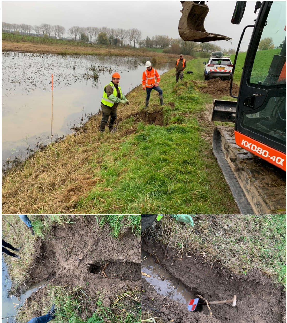
Figuur 12 Ontgraving van een bevergraverij [foto's: Frans van den Berg, Deltares]
