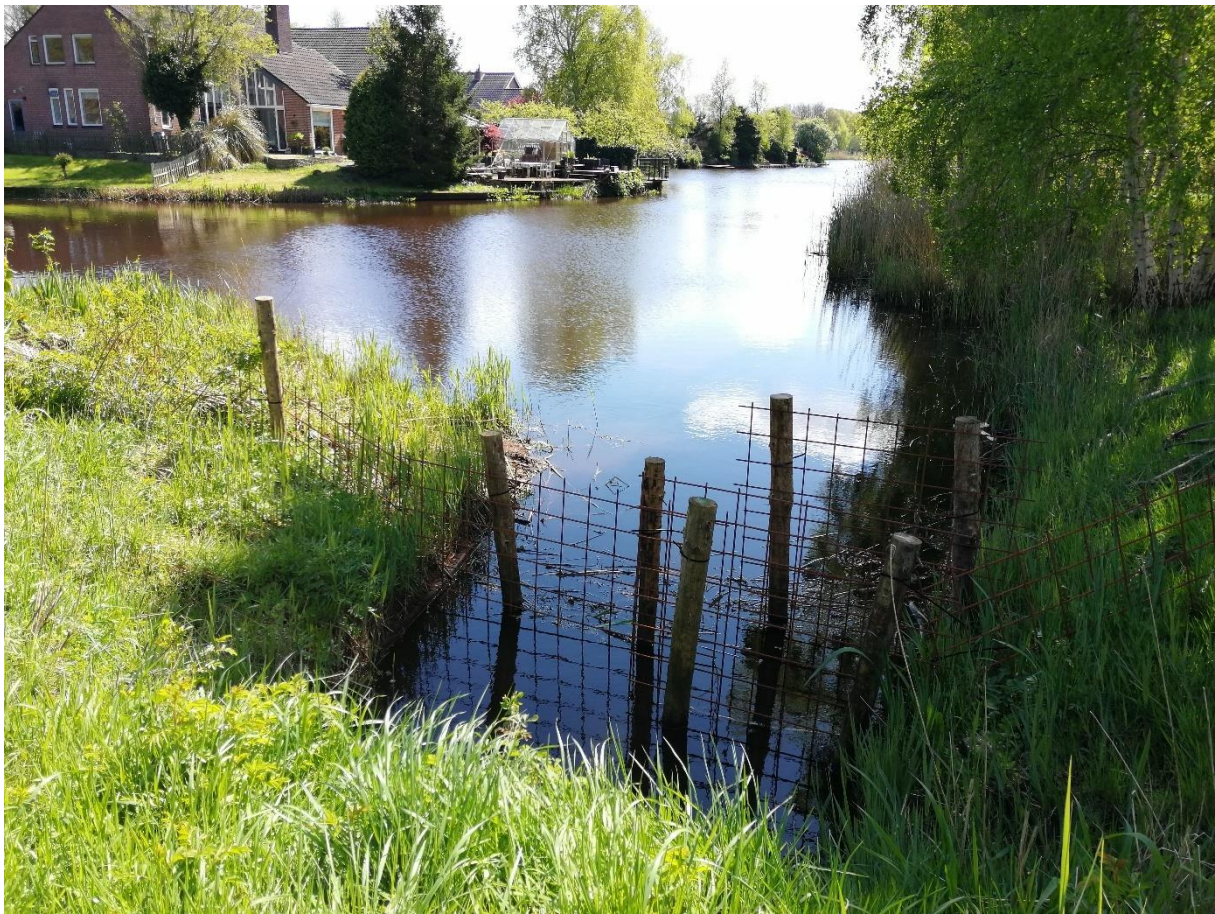
Figuur 33 Hekwerk voorkomt dat bevers de duiker kunnen afdammen. Het hekwerk is passeerbaar voor de bever, maar niet met grote takken.
