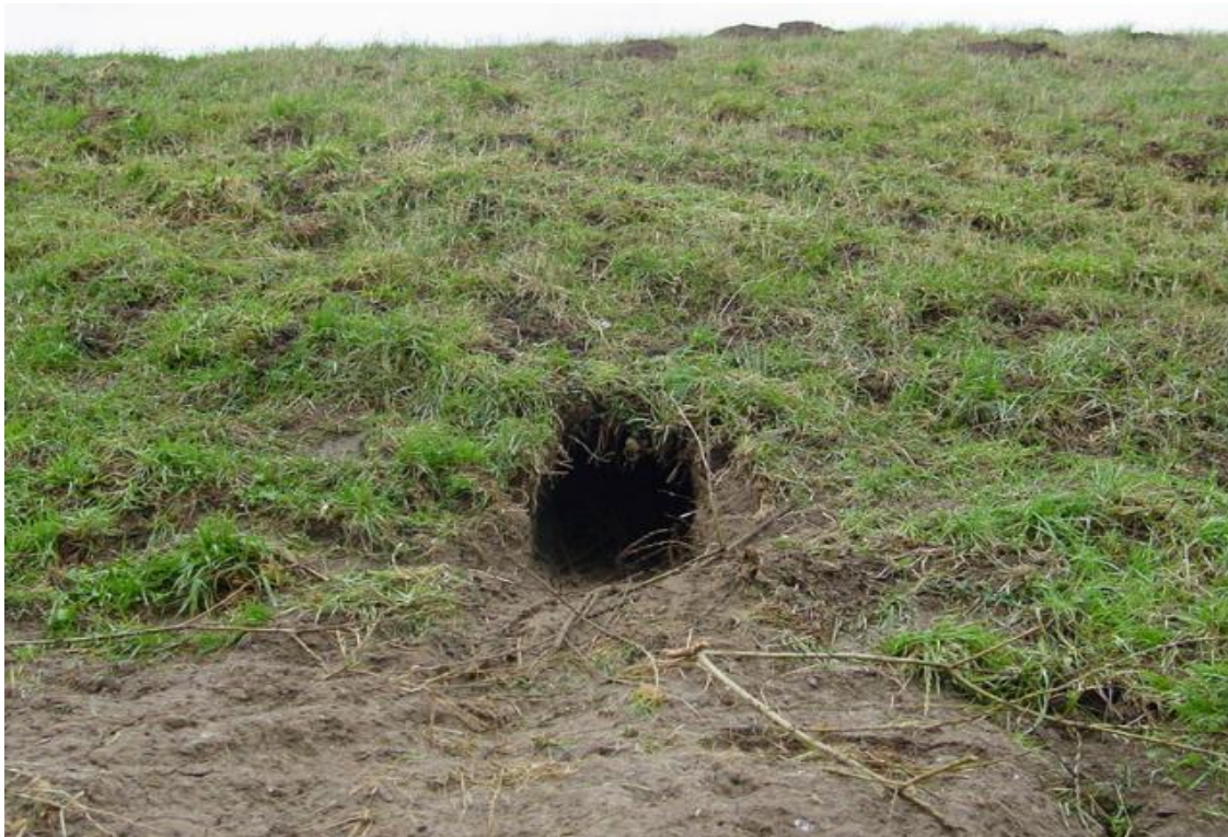
Figuur 1.1. Bevers hebben een hol gegraven in de kering tijdens een hoogwater (foto: Waterschap Rivierenland).
