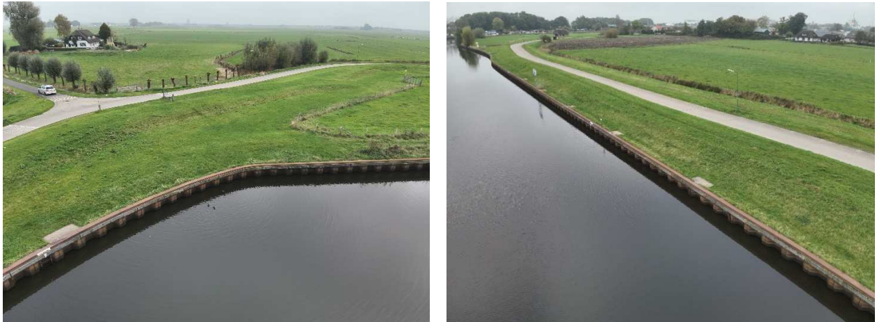
Figuur 12 Stalen damwand langs de Eem, 19 oktober 2024
