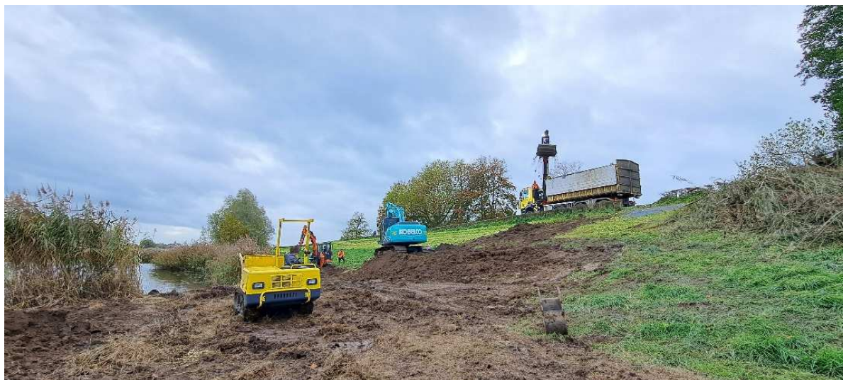
Figuur 16 Verflauwen naar 1:3 talud Veessen 2022
