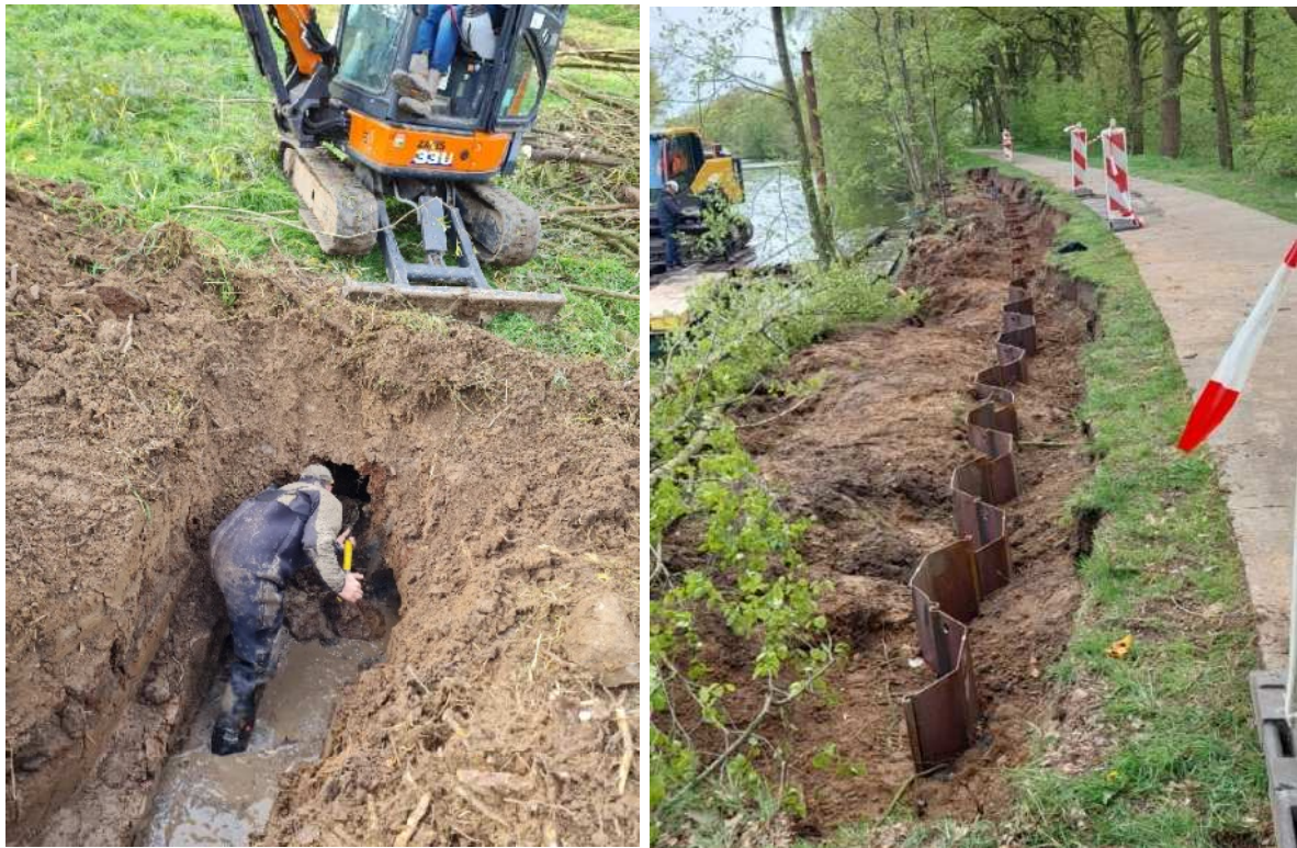
Figuur 15 Opengraven beverhol, IJsseldijk Veessen 2022 (links) en plaatsing van 50m stalen damwand bij Epe tussen de Grift en het Apeldoorns kanaal, 2023 (rechts)
