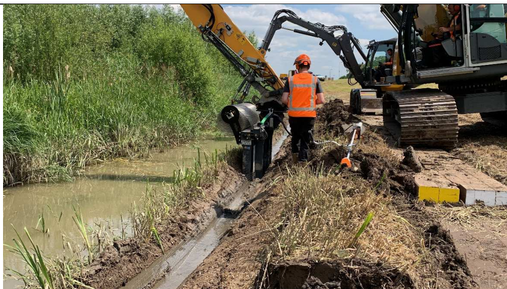
Figuur 23 Grift talud bij Wenum-Wiesel 2020
