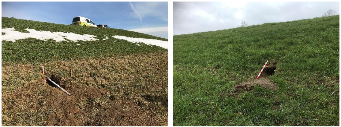
Figuur 2.6 Beverholen in dijken van Waterschap Rivierenland in februari 2021 (Evers & Cornelisse, 2021:21, 22).
