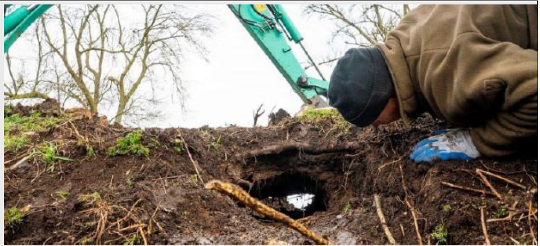
Figuur 4.2 Doorgraving van een regionale kering door een bever (Zijpkade bij Vianen, foto Waterschap Rivierenland).
