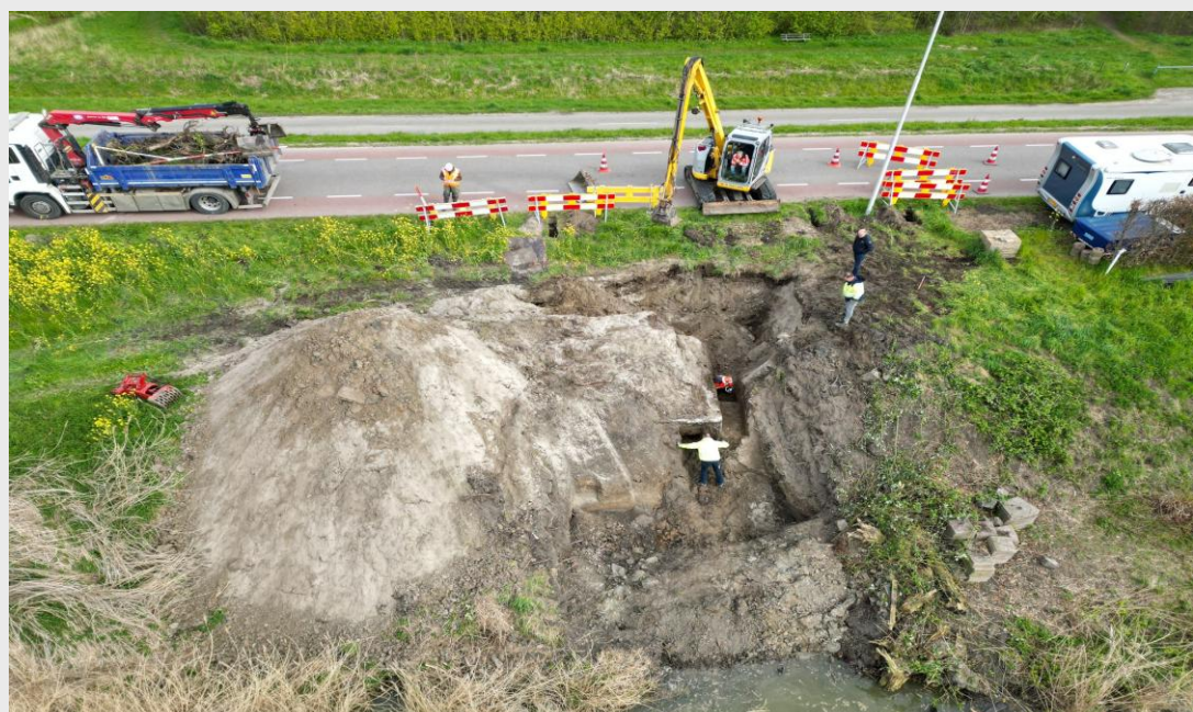
Figuur 6.2 Weg in Zuid-Holland met een beverhol tijdens uitgraven daarvan (Van der Baan, 2025:22).
