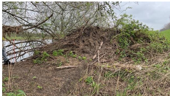
Wanneer een dijktaalud betrekkelijk dicht bij het water is, kan een bever ook onder dagelijkse omstandigheden (te onderscheiden van een hoogwatersituatie en extreme droogte) in een dijk gaan graven. Een voorbeeld is getoond in Figuur 2.3. Dit betrof een bevergraverij van ruim 20 meter diep de dijk in (loodrecht op de oever) met een viertal kamers bij een binnendijks wiel 2 . De beverfamilie woonde daar al enige jaren voordat werd ingegrepen omwille van de waterveiligheid, nadat door uitzonderlijke droogte de ingangen van 8 hollen in de oever zichtbaar waren geworden (Kapinga, 2022).
