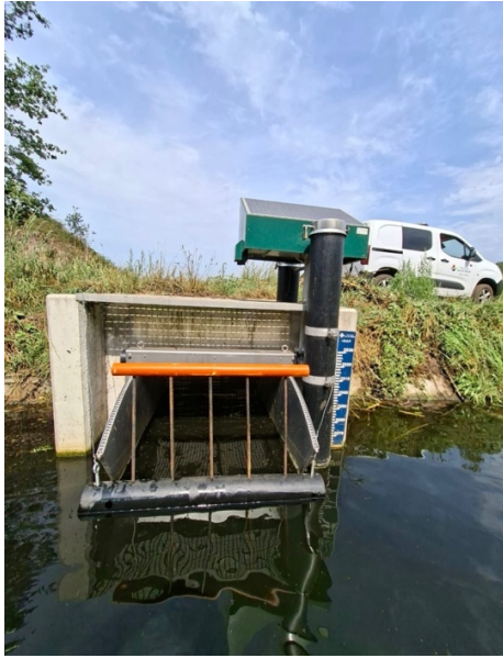
Afbeeldingen 4 & 5: mobiele roosters op locatie voor stuw
