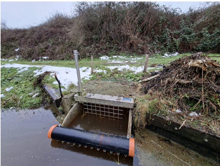
Afbeelding 8: Drijver in het water en de hoeveelheid takken die uit de stuw is gehaald.
