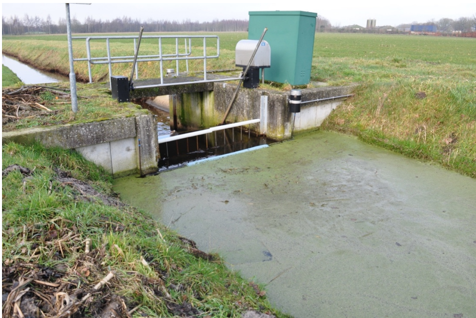
Afbeelding 18: Vuil blijft hangen achter de met het peil meebewegende balk
