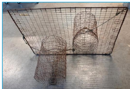
Afbeelding 13: Duikerafsluiting met twee verdrinkingskooien. (Eigen foto, gemaakt op 8 april 2025).
