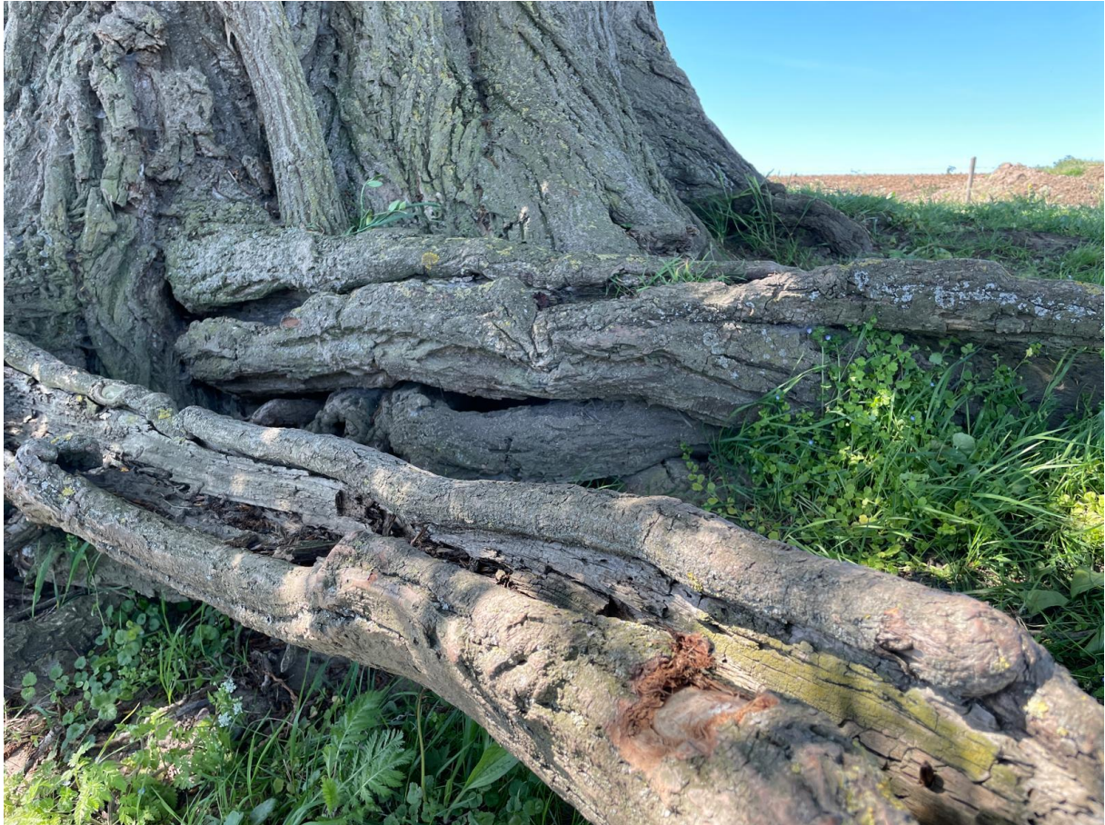
Onbehandelde wortelaanlopen met vraatschade.
