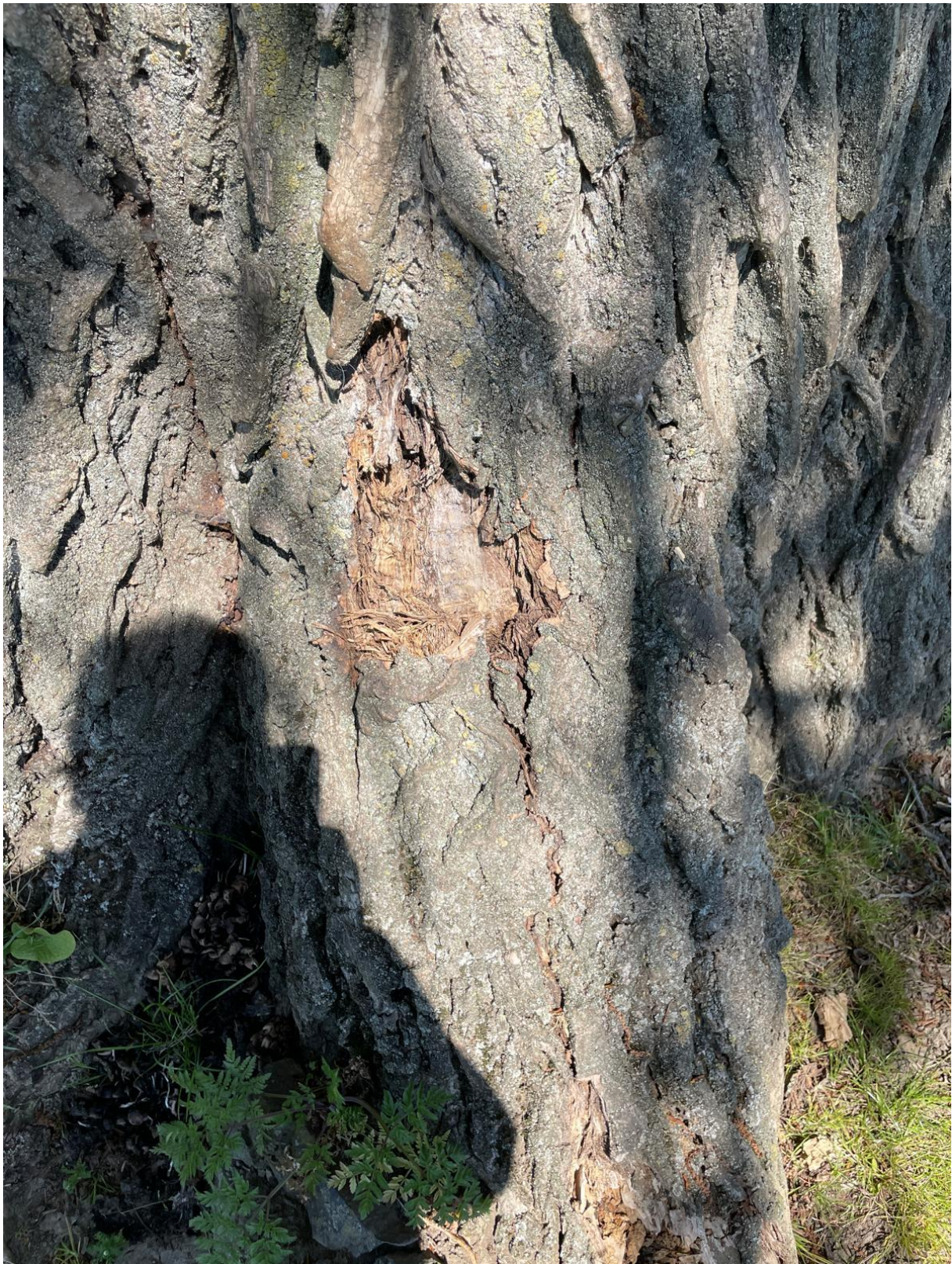
Boom met bastschade, geen aantoonbare vraatschade. Aanleiding om weer te behandelen? Mogelijke invalspoort voor vraatschade.
