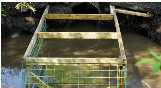
Afbeelding 2. Kooi met gaas voor een duiker om te voorkomen dat een bever het dichtstopt met takken en modder (S. Lisle).
