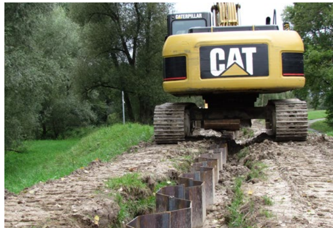
Afbeelding 1. Damwanden die in de oever zijn geplaatst om graafschade te voorkomen (R. Campbell-Palmer).
