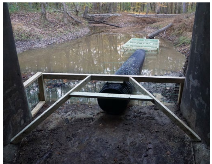
Afbeelding 7. Ook voor grotere onderdoorgangen kan het systeem worden toegepast. De foto geeft de situatie bij relatief lage waterstanden (S. Lisle).
