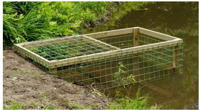
Afbeelding 3. Kooi met gaas voor een duiker om te voorkomen dat een bever het dichtstopt met takken en modder (S. Lisle). Aan de kant van de oever is de bovenkant dicht om te voorkomen dat de bevers van boven materiaal inbrengen.
