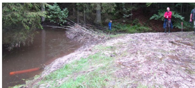
Afbeelding 3. Instroom opening van een 'Beaver deceiver' naast een beverdam, zie ook afbeelding 4 (R. Campbell-Parker).
