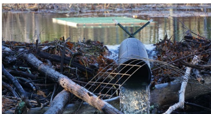
Afbeelding 5. Beverdam met een 'Beaver deceiver' in de vorm van een dubbelwandige PE buis. Op de achtergrond is het filter van de instroomopening te zien. Op de voorgrond het gebogen gaas dat de bevers bij de uitstroomopening weghoudt. Met een stalen kruis wordt de buis op zijn locatie gehouden (S. Lisle).
