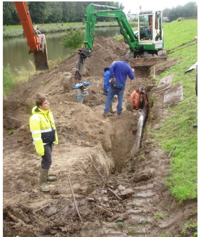
Afbeelding 3. Holenstelsel dat wordt open gegraven in een primaire waterkering, met behulp van twee graafmachines (V. Dijkstra).
