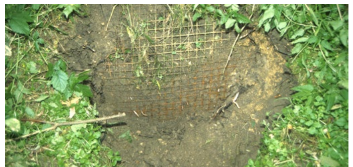
Afbeelding 2. Gaas in de grond om te voorkomen dat bevers (verder) graven. Om te voorkomen dat door roest het gaas relatief snel vergaat, kan gekozen voor roestvrij staal, al is dat een duurdere optie (G. Schwab).
