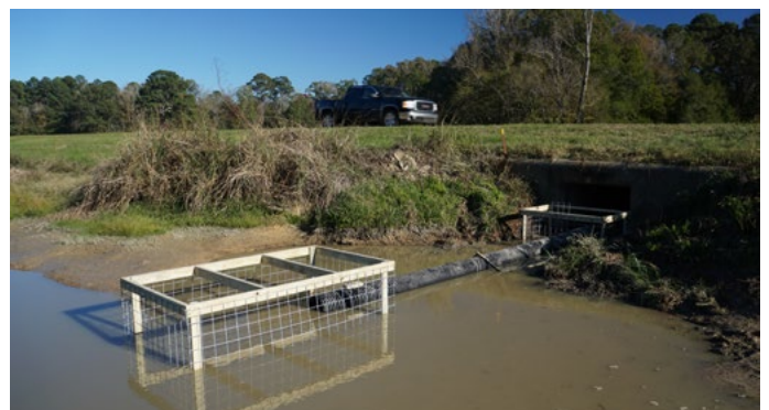
Afbeelding 4. Kooi met gaas voor een duiker om te voorkomen dat een bever het dichtstopt met takken en modder, waarbij een verlenging met een buis en filter is toegepast. De foto geeft de situatie bij relatief lage waterstanden (S. Lisle).
