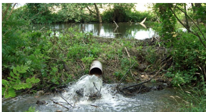
Afbeelding 2. Beverdam met een 'Beaver deceiver'. In dit geval zonder filter bij de instroomopening. Ook dat kan soms goed functioneren (G. Schwab).
