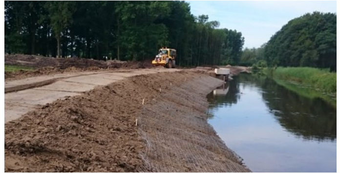
Afbeelding 3. Gaas aangebracht langs een oever bij de Dommel. Op het gaas wordt nog een afdeklaag aangebracht (Waterschap De Dommel).
