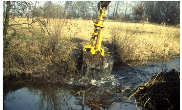
Afbeelding 2. Verwijderen van een dam met een kraan (G. Schwab).
