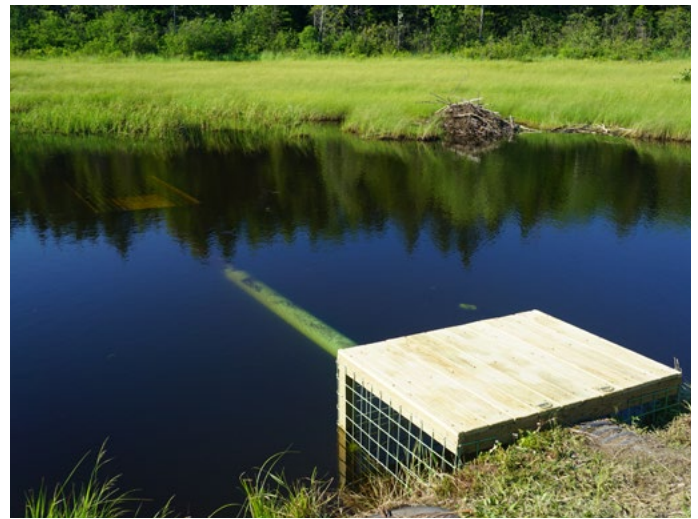
Afbeelding 6. Kooi met gaas voor een duiker om te voorkomen dat een bever het dichtstopt met takken en modder, waarbij een verlenging met een buis en filter is toegepast (onder water). In de achtergrond een beverburcht (S. Lisle).
