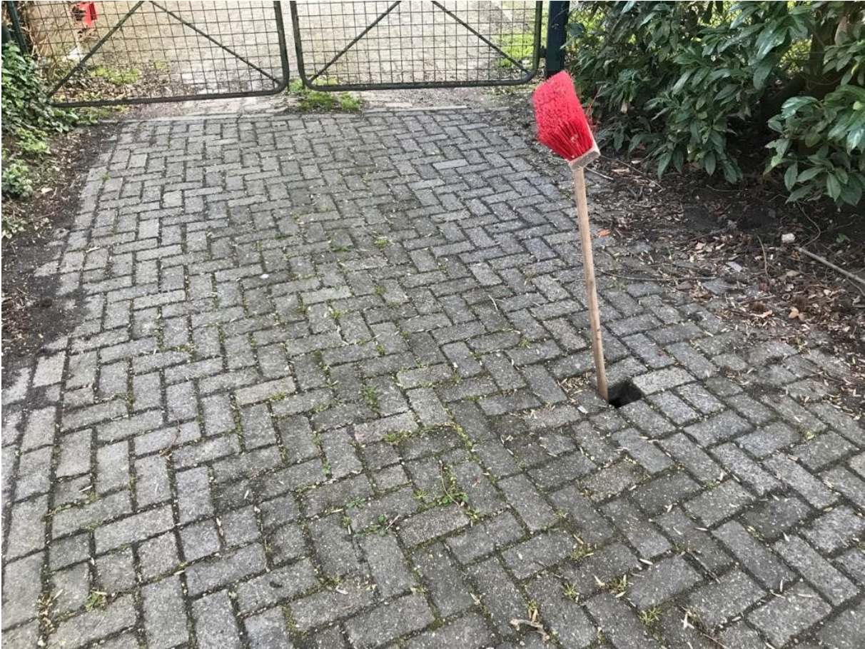
Foto 1. De toegangsweg naar de loods is door bevers ondergraven en daarom vanwege de veiligheid afgesloten (foto: Gemeente Oss).
