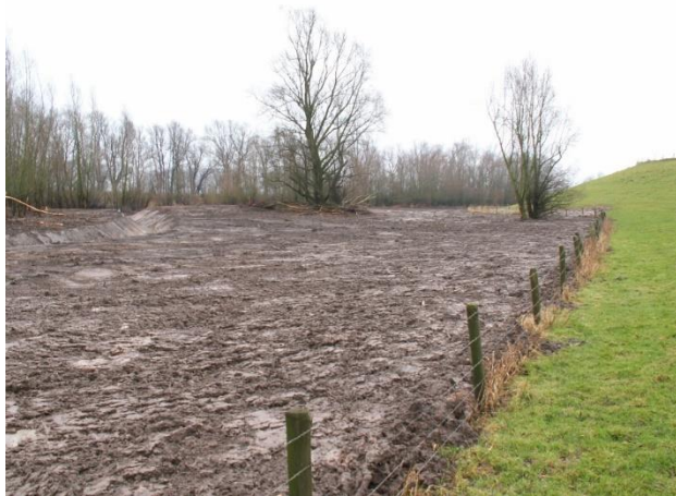
Figuur 4-4: Verleggen van een watergang in de Ooijpolder bij dijkpaal EN-053.
