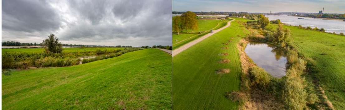
Figuur 4-10: Een voorbeeld bij de waaldijk nabij Slijk-Ewijk. De linker afbeelding geeft de originele situatie weer met een begroeide oever. Het plaatje rechts laat de situatie zien nadat de oever vrijgemaakt is van bepanting.
