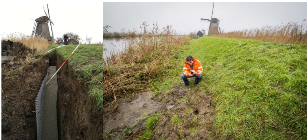
Figuur 4-7: Gaaswapening met bentoniet-sleufvulling bij de Hoge-Boezemkade-Overwaard ter hoogte van Kinderdijk
